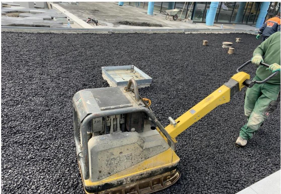
Abbildung A 10. Rüttelplatte Wacker-Neuson DPU 6555 Heh, Schallquelle Nr. 25.
