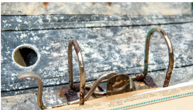
Schimmelpilzbefall kann auch in Büros und Archiven auftreten.
