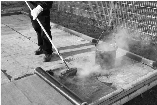
Bild 3. Verkleben der Dachpappe mit Teerklebemasse.
