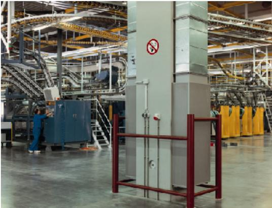
Abbildung 10: Anordnung der Quellluftdurchlässe
