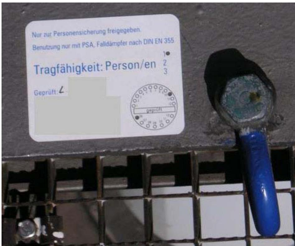
Bild 14: Beispiel für die Kennzeichnung der Sachkundigenprüfung an einer permanenten Anschlagseinrichtung, Quelle: DFMG
