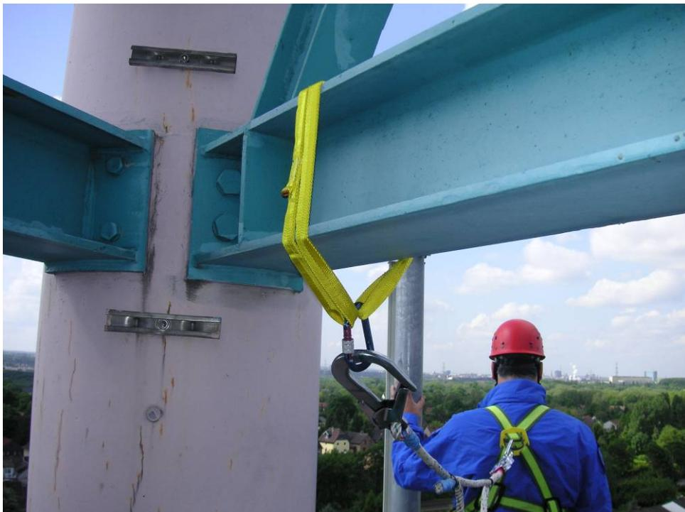
*Bild 11: Beispiel für eine Anschlagmöglichkeit am Bauwerk/an einer Konstruktion – Träger, Quelle: DFMG*
