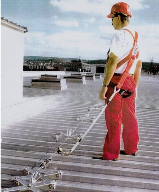
*Bild 9: Beispiel für eine permanente Anschlagereinrichtung mit horizontaler Seilführung und beweglichem Anschlagpunkt*
