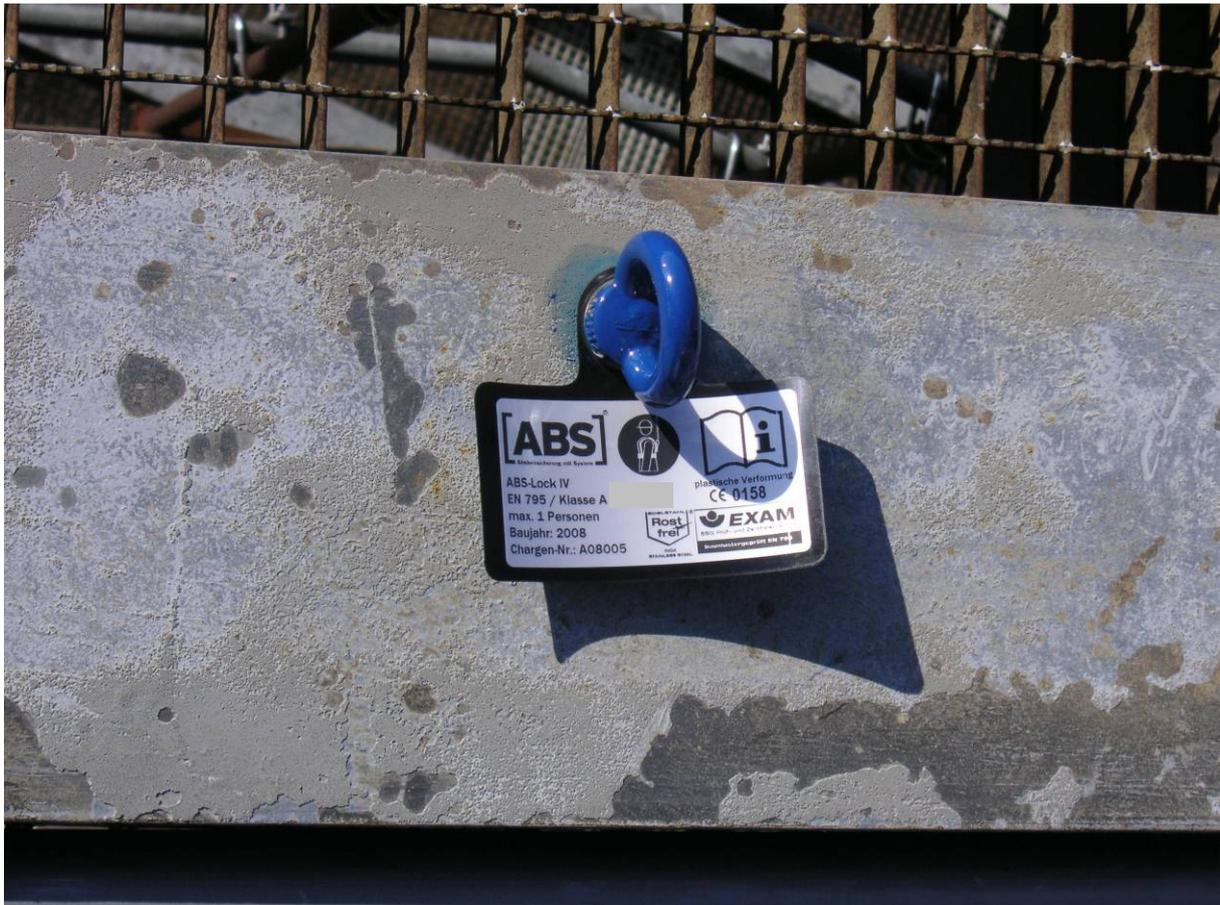
Bild 3: Beispiel einer Anschlageinrichtung mit CE-Kennzeichnung
