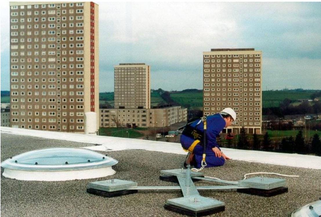
*Bild 7: Beispiel für eine temporäre Anschlagereinrichtung auf Eigengewichtsbasis*
