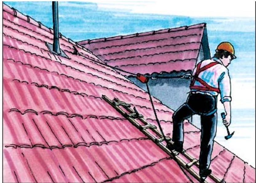
**Risikobeurteilung:** Durch Schlaffseilbildung kann ein Sturz über die Traufkante erfolgen. Als Verletzungsschwere sind schwere Prellungen bzw. schwere Knochenbrüche auf Grund eines Pendelsturzes und durch Anprallen an die Fassade möglich. Nach dem Auffangvorgang besteht durch die Hängeposition unterhalb der Traufe keine Möglichkeit der Selbstrettung.
