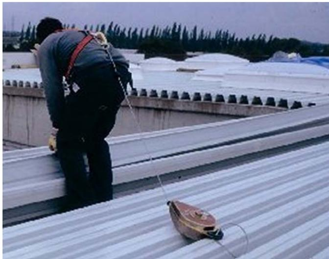
**Risikobeurteilung:** Es besteht die Gefahr des Stolperns oder des Abrutschens mit der Folge eines Sturzes über die Blechkante. Hierbei sind aufgrund des Fallweges leichte bis schwere Prellungen oder auch leichte Knochenbrüche möglich. Beim Sturz über die Trapezblechkante besteht durch das freie Hängen unterhalb der Dachebene nach dem Auffangvorgang völlige Hilflosigkeit.
