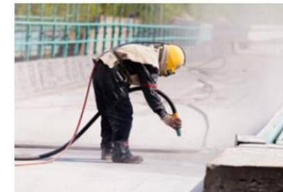
Abbildung 1 – Manuelle Freistrahlarbeiten – Wenn bei den Arbeiten mit Gefahrstoffen zu rechnen ist, sollte vorzugsweise ein glatter einteiliger Schutzanzug getragen werden, um Verschleppungen zu vermeiden.
