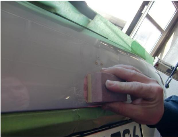
**Bild 1: Anschleifen der Schadstelle**
