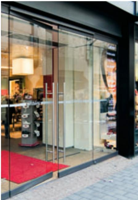
Bild 2: Glastür aus ESG
