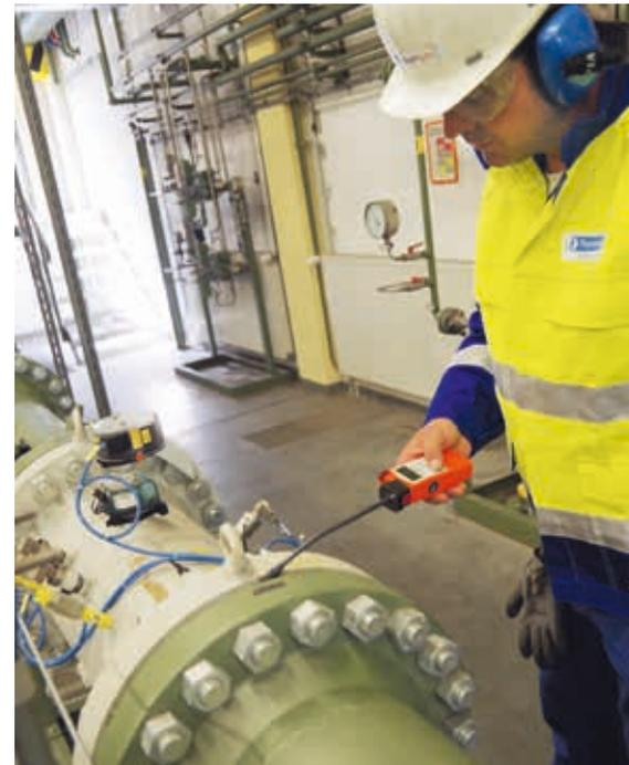
Inspektion in einer Gasanlage mit Überwachung der Gaskonzentration.
