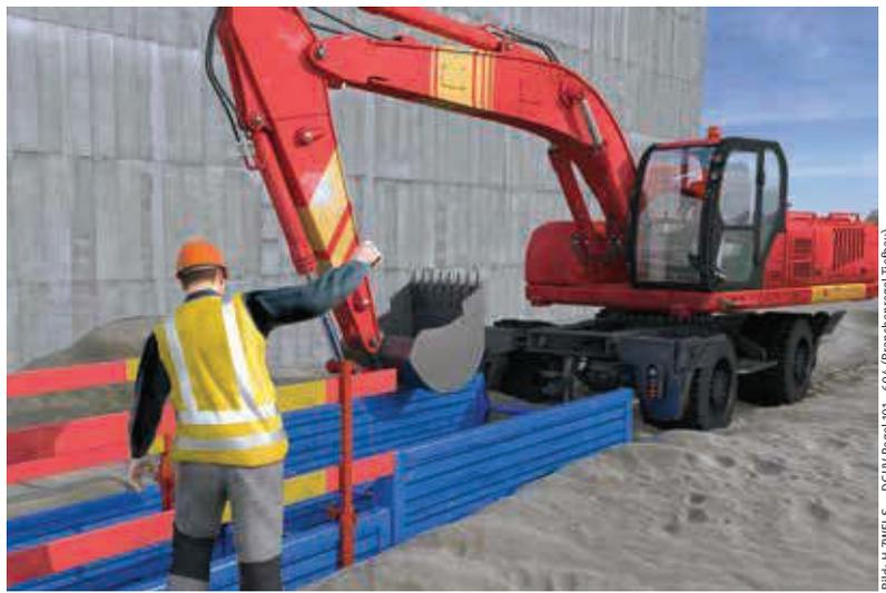
Abb. 5 · Graben ohne Absturzsicherung im Arbeitsbereich des Baggers während des Grabenaushubs
