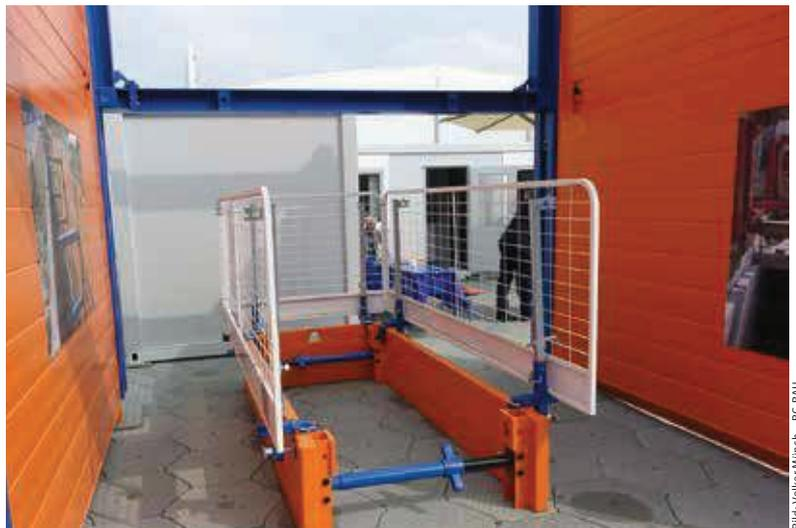
Abb. 6 · Aufsatzelemente Absturzsicherung
