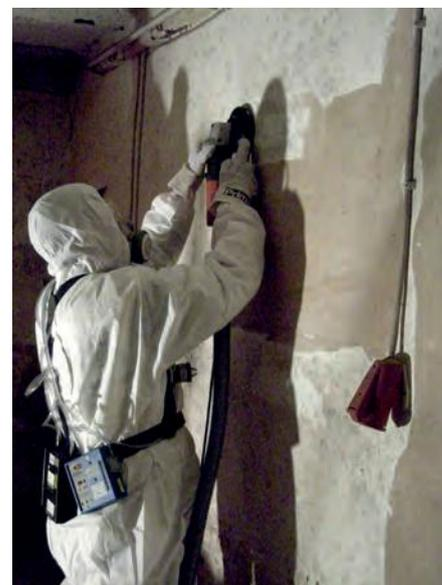
Abb. 3: Entfernen schimmelpilzbelasteter Oberflächen mit abgesaugtem Schleifgerät
