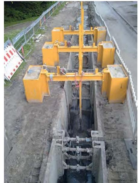
Abb. 6: Auftriebssicherung beim Einbringen von Flüssigboden
