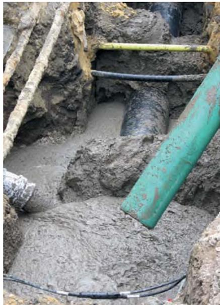
Abb. 5: Auflagerbänke und Auftriebssicherungen aus plastischem Material
