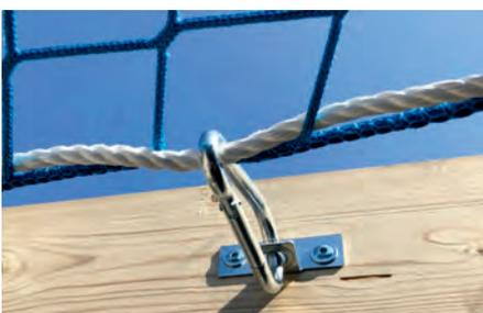
Beim Einsatz von Schutznetzen 3 m x 1 m vom Typ S-A1-Q60 (Schutznetz Typ S mit Randseil, quadratische Maschenanordnung und Maschengröße kleiner 60 mm) sollte die maximale Fallhöhe 1 m nicht übersteigen.
