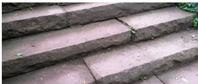
Abb. 16 Außentreppe mit erhöhtem Abrieb
